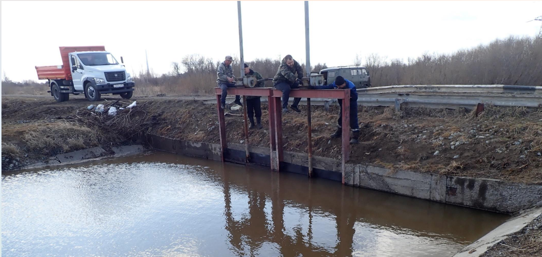
Рисунок 12. Патрушевская осушительная система. Установка затворов.
