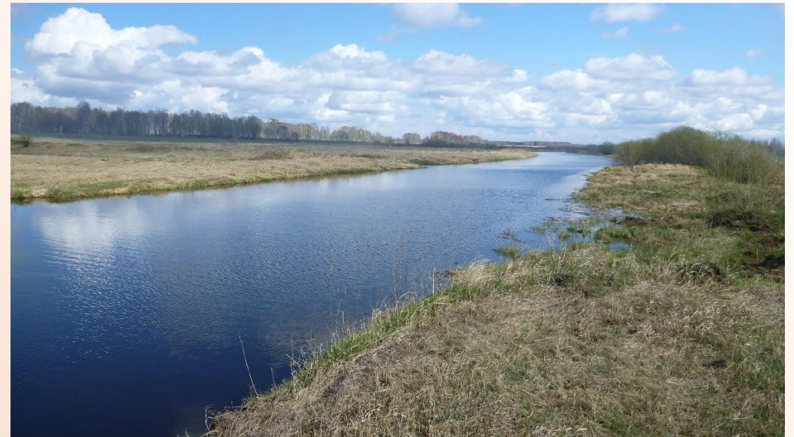
Рисунок 4. Патрушевский магистральный канал
